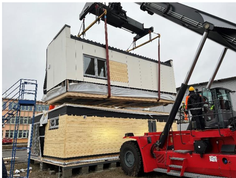
Fotografia 22 - Montaż modułu pierwszego piętra. Wersja budynku z dachem płaskim.
