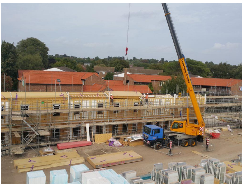
Fotografia 25 - Montaż panelu stropowego [Cygnum].
