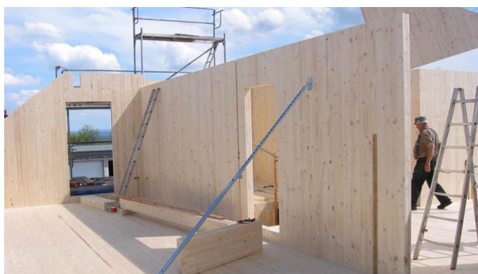
Fotografia 6 - Ściany i strop z DKK podczas montażu [Eugen Decker].
