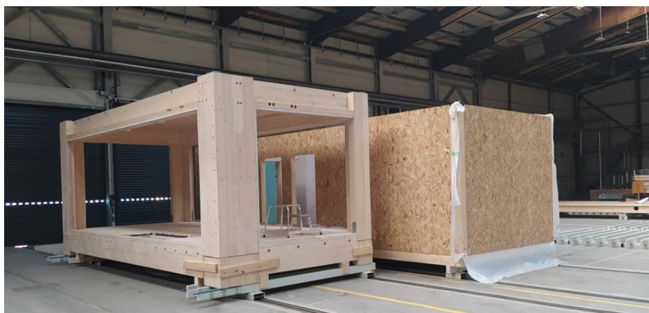
Fotografia 13 – Konstrukcja modułów, od lewej: ramowy z drewna masywnego, z lekkiego szkieletu drewnianego. Źródło: materiały Andrewex Construction.
