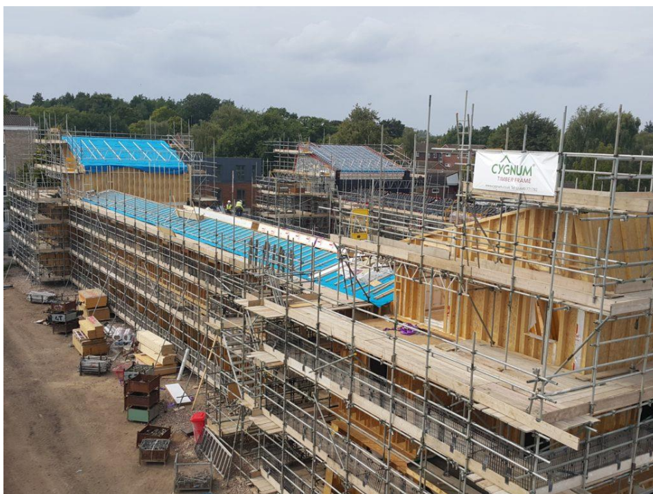
Fotografia 24 - Osiedle podczas budowy [Cygnum].
