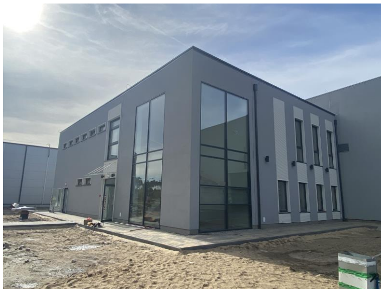
Fotografia 28 - Widok wykończonego budynku od strony rdzenia żelbetowego. Źródło: materiały Andrewex Construction.
