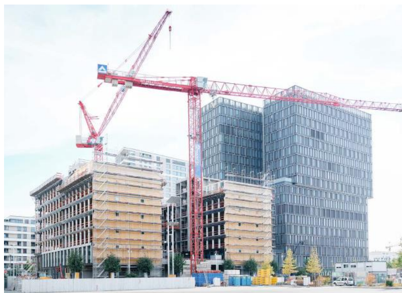
Fotografia 35 - Timber Pioneer podczas montażu - widok na ściany usztywniające z DKK [UBM Development].
