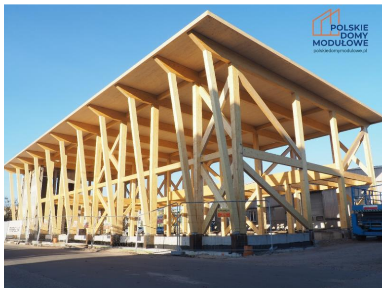
Fotografia 31 - Budynek biurowo-laboratoryjny w Pisz - widok na układ słupowo ryglowy z zastrzałami. Źródło: materiały Andrewex Construction.
