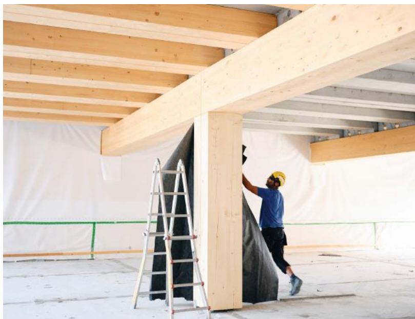
Fotografia 36 - Shup i podciąg z DKW [UBM Development].
