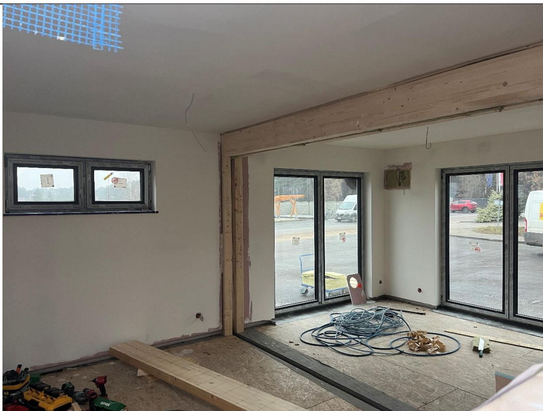
Fotografia 21 - Parter z widoczną granicą między modułami przed połączeniem konstrukcyjnym i pracami wykończeniowymi.
