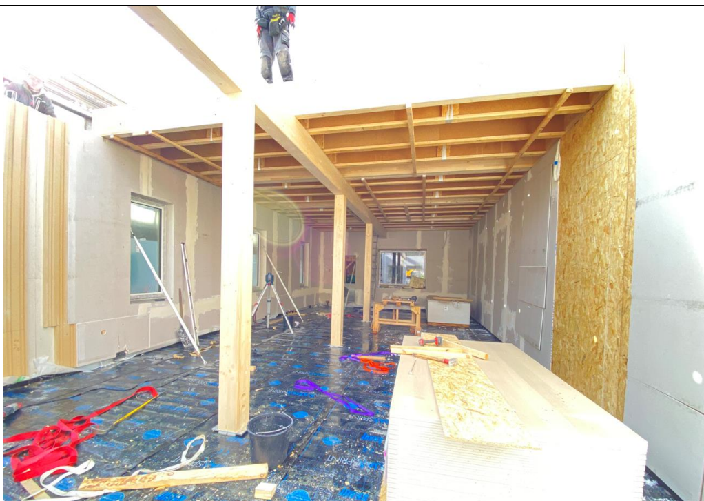
Fotografia 27 – Montaż paneli stropowych – widok parteru w stolówce. Źródło: Materiały Andrewex Construction.
