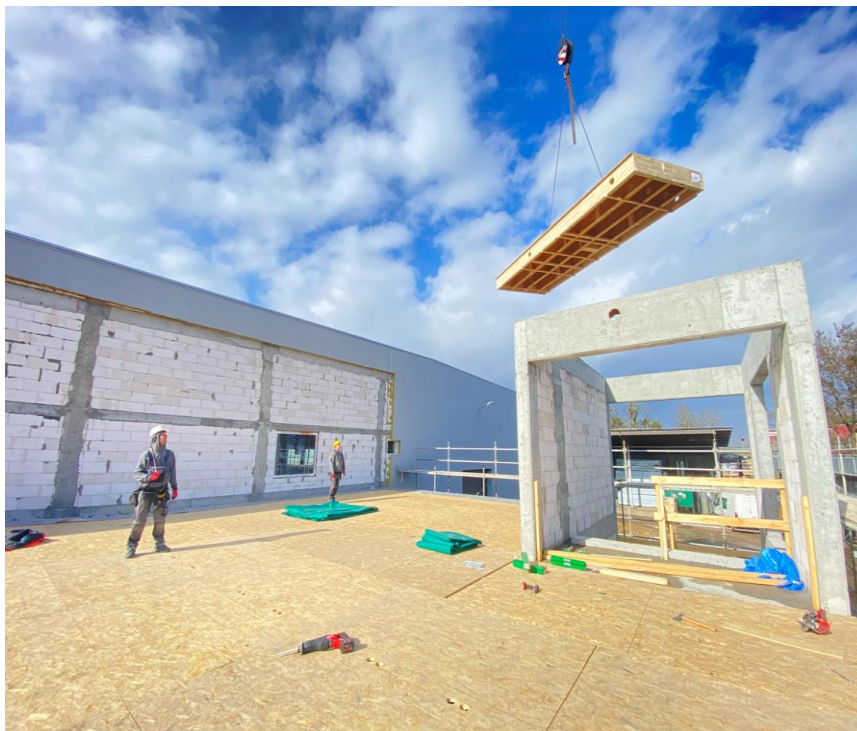
Fotografia 29 - Montaż elementów stropowych, widok na rdzeń żelbetowy na piętrze. Źródło: materiały Andrewex Construction.
