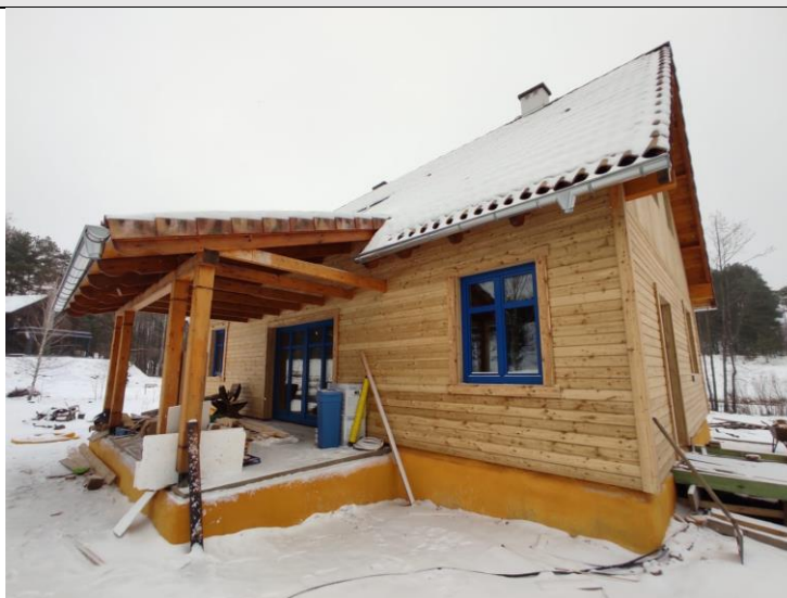
Fotografia 37 - Widok z zewnątrz podczas robót wykańczających. Źródło: materiały udostępnione Modulam.
