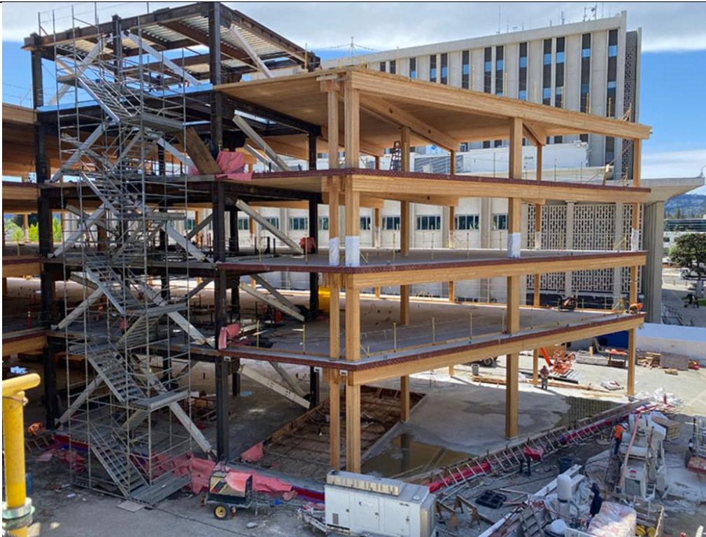
Fotografia 33- Konstrukcja budynku w Redwood City podczas montażu. Po lewej stronie widoczny stalowy prętowy rdzeń usztywniający [Western Wood Structures].
