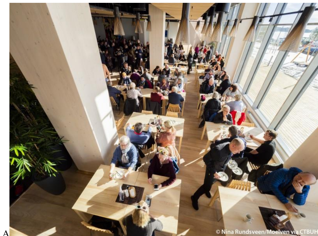
Fotografia 18 - Odsłonięte masywne słupy konstrukcji w lokalu gastronomicznym [Moelven].
