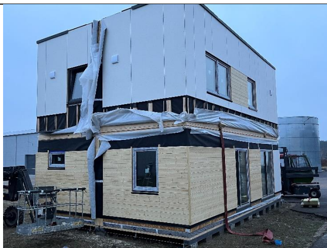
Fotografia 23 - Moduły posadowione przed połączeniem. Wersja budynku z dachem płaskim.
