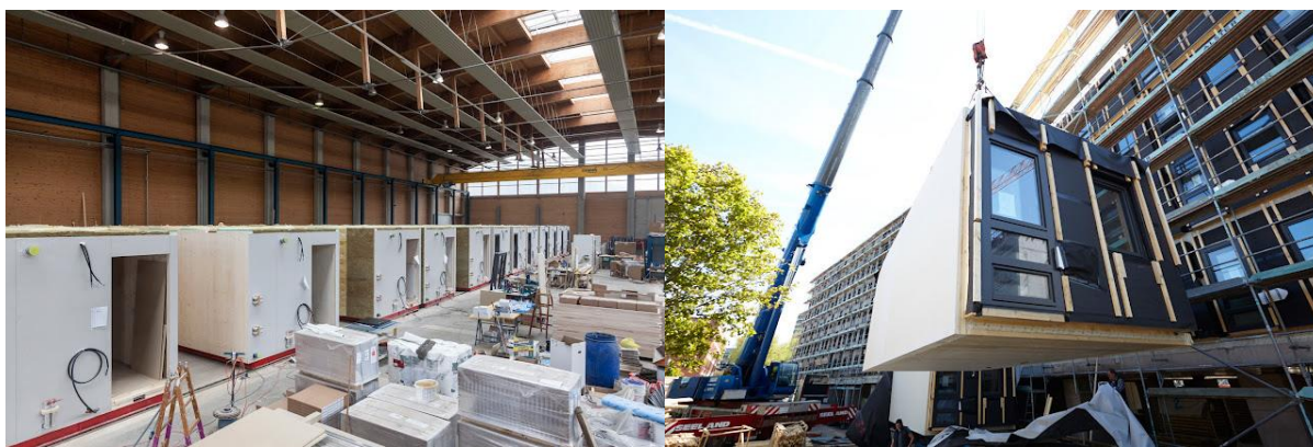
Fotografia 30 - Moduły budynku Woodie, od lewej: w zakładzie prefabrykacji, podczas montaż [Prefabium Blog].
