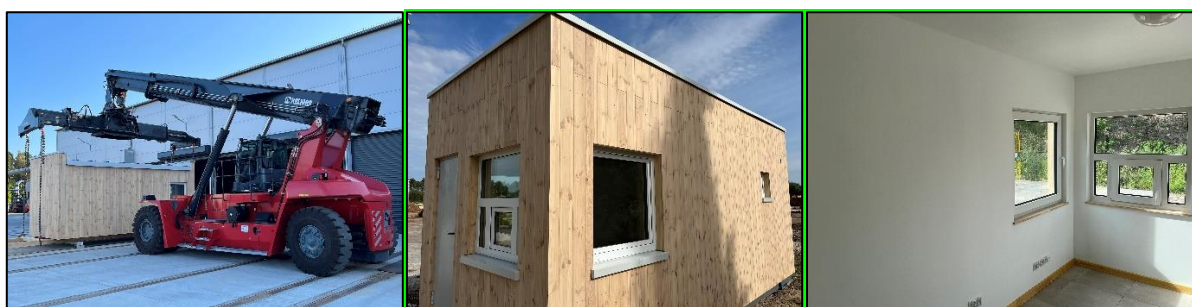
Fotografia 12 - Budynek jednomodułowy w pełni wykończony, od lewej: przenoszenie w zakładzie prefabrykacji, moduł posadowiony, wnętrze. Źródło: Materiały Andrewex Construction.
