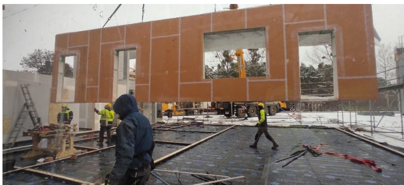
Fotografia 11 - Panel ścienny podczas montażu. Źródło: materiały Andrewex Construction.
