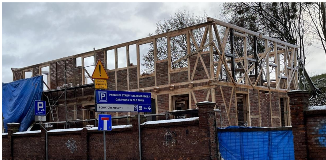
Fotografia 9 - Budowa w konstrukcji szachulcowej..
